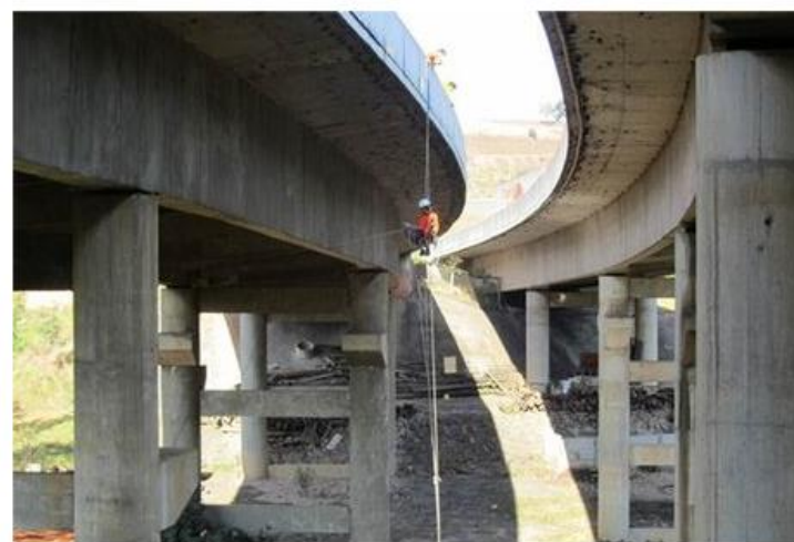
Inspeção de uma ponte de concreto.
