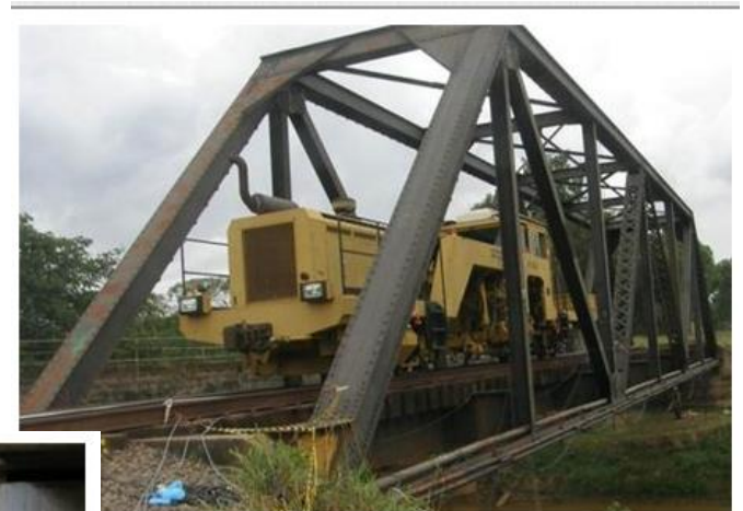
Monitoramento de uma ponte metálica sob carregamento.
