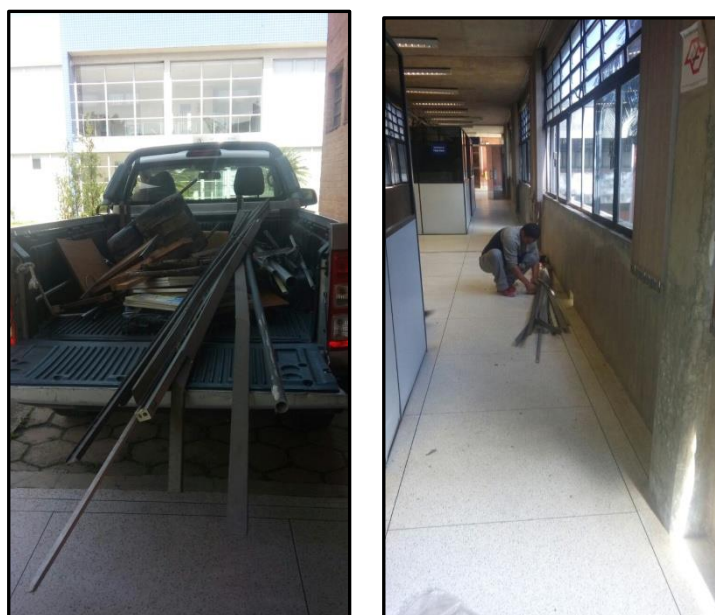
Figura . Carregamento e descarregamento dos resíduos inservíveis do prédio da Administração.
