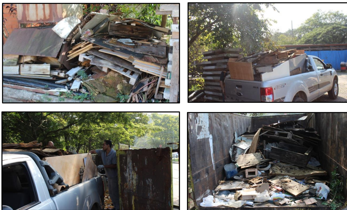
Figura 19. Carregamento e descarregamento dos resíduos inservíveis da Civil na primeira viagem.
