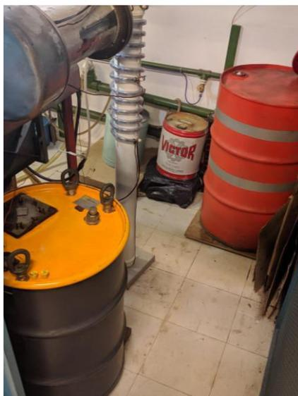
Figura 4. Tonéis com ascarel para descarte.
