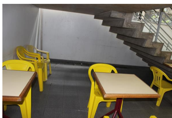
Figura 48. Local após a operação.
