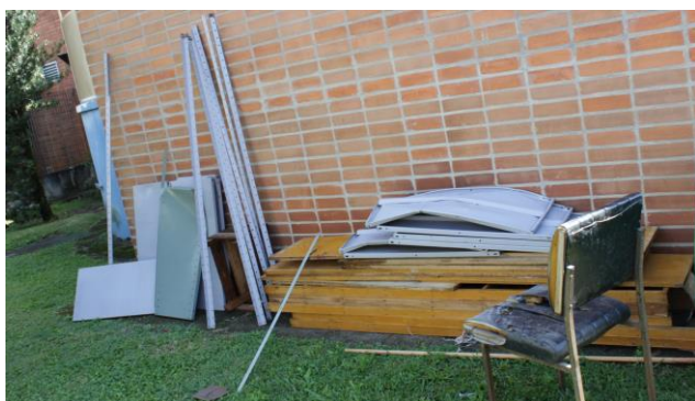
Figura 6. Resíduos inservíveis do prédio da Administração.
