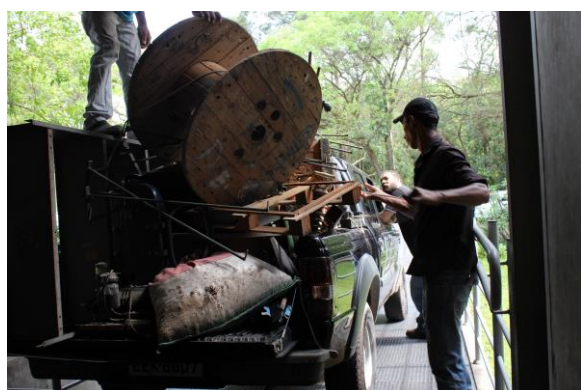
Figura 43. Carregamento de materiais
