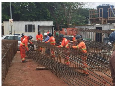
Figura: Desmontando as ligações soldadas entre das barras para apertar a gaiola
