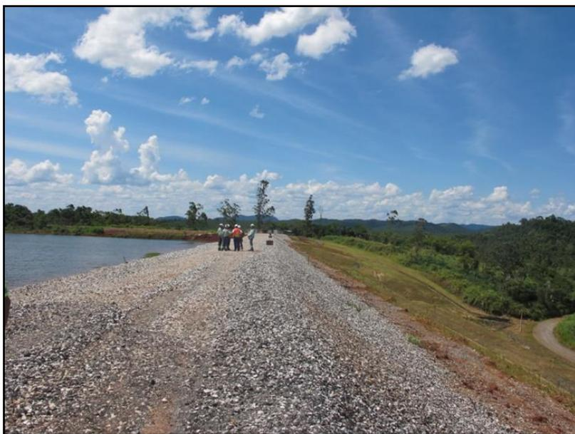
**Foto 20: Barragem de terra com alteamento a jusante, da Vale Fertilizantes, em Cajati.**
