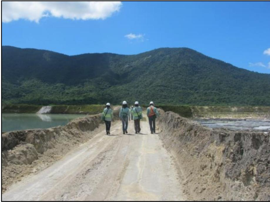
**Foto 14: Dique de separação entre duas bacias utilizadas para decantação da lama com fosfogesso, na Vale Fertilizantes, Unidade II em Cubatão.**
