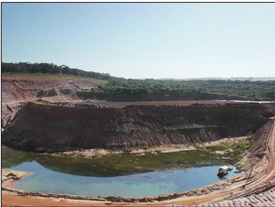
**Foto 6: Barragem de terra em cava exaurida, para rejeitos de mineração da Mineração Descalvado, em Descalvado. Observa-se ao fundo, a parte da cava que está sendo preenchida com os rejeitos argilosos das operações do beneficiamento do minério.**
