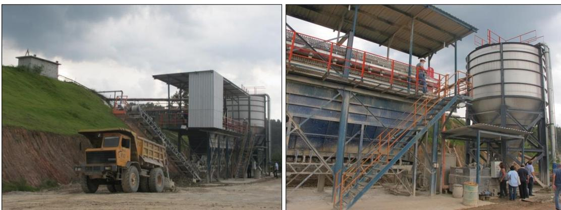
**Fotos 8 e 9** Instalações da empresa Pedrix Ltda., em Caieiras, que se utiliza da tecnologia de *drystack* (espessamento e filtragem).
