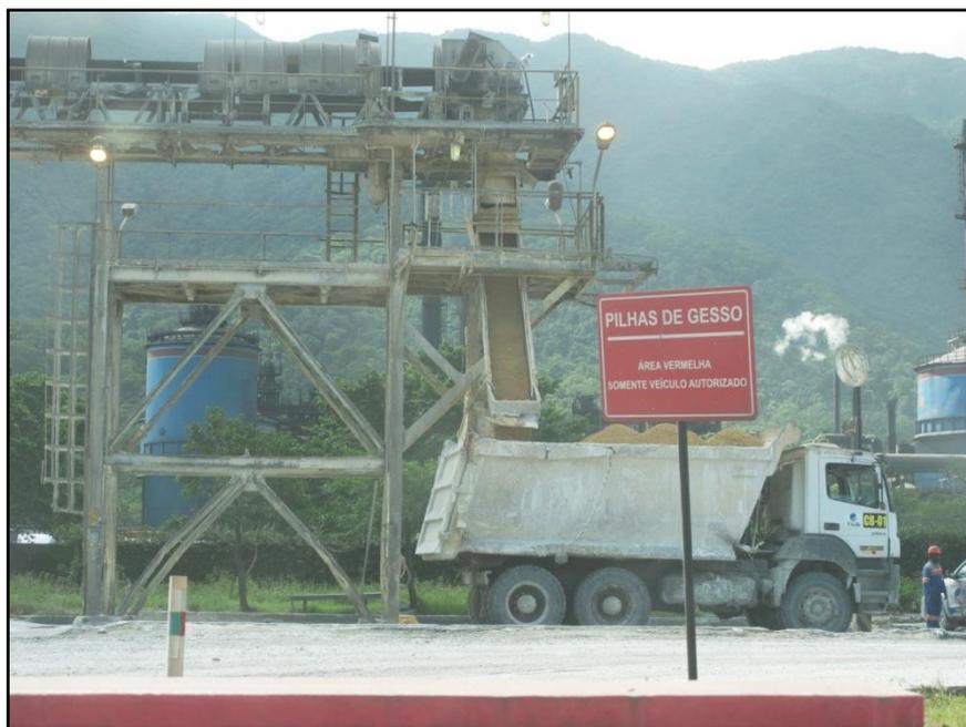
**Foto 17: Instalação de filtragem da empresa Anglo American em Cubatão, para a produção de fosfogesso.**
