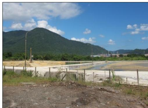
**Fotos 18 e 19: Pilha de fosfogesso e bacia de decantação para a contenção do material carregado dessa pilha (percolado), pelas águas pluviais.**
