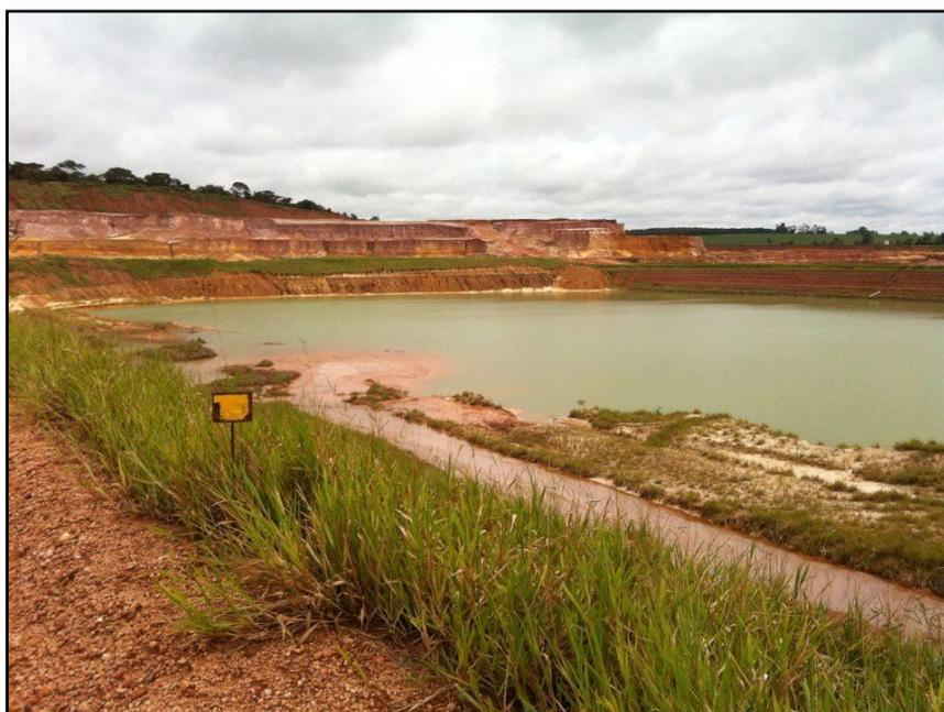
**Fotos 8 e 7: Cava exaurida utilizada para decantação dos rejeitos da mineração, da Mineração Jundu, em Descalvado.**
