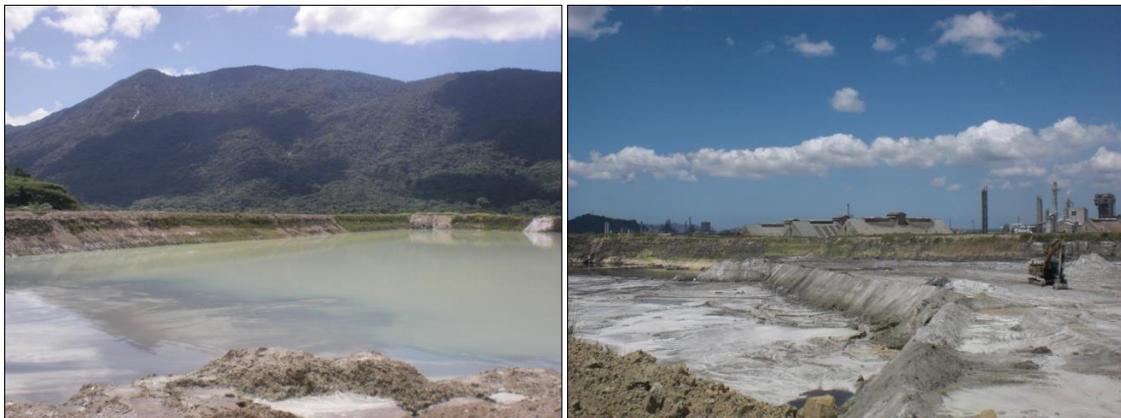
**Fotos 15 e 16: Bacias utilizadas para decantação da lama com fosfogesso. À esquerda bacia em fase de enchimento e à direita, bacia com fosfogesso já decantado e em fase de retirada, para as pilhas de armazenamento.**
