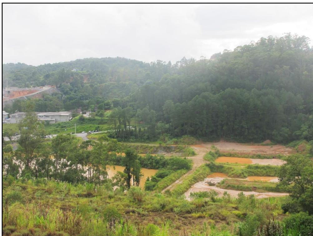
**Foto 3: Barramento de terra em bacia de decantação de águas pluviais na Pedreira Sargon Ltda., em Santa Isabel.**
