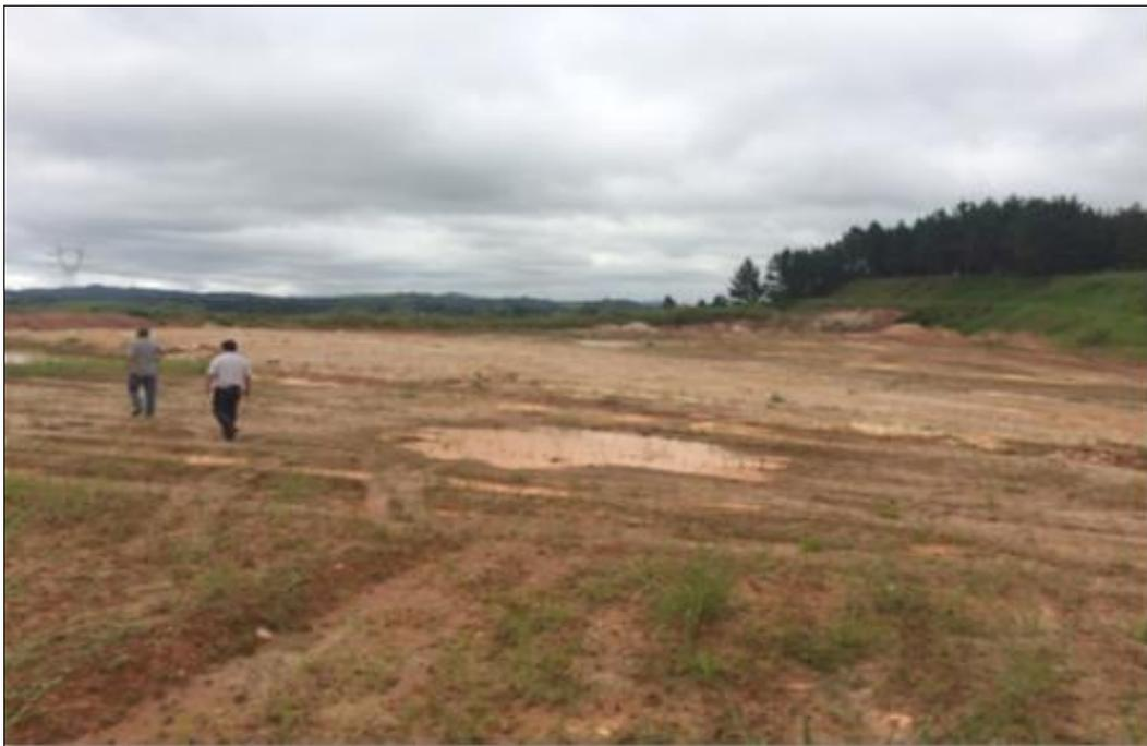
**Foto 31: Detalhe do estágio atual de recuperação de bacia de rejeito- Barragem 2.**
