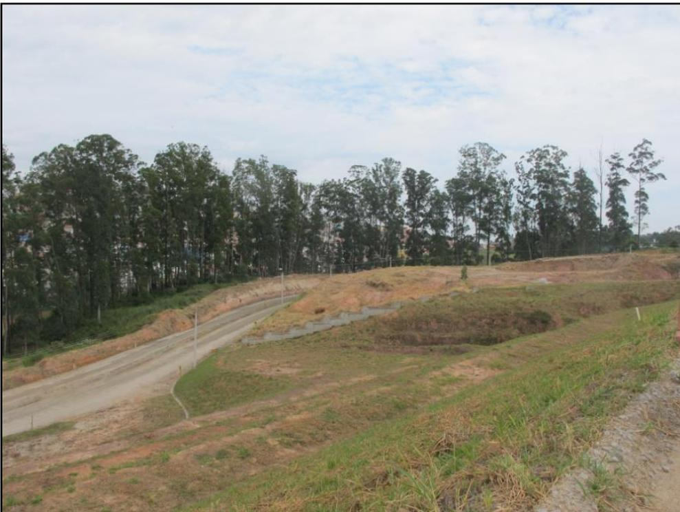
**Fotos 1 e 2: Barragem de terra com alteamento a jusante para rejeitos de mineração da Pedreira Juruáçu, do Grupo Embu S.A., em São Paulo.**
