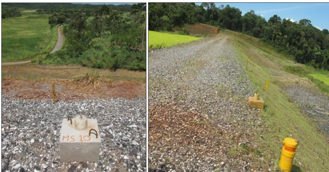
**Fotos 21 e 22: Detalhe de marco topográfico para a medição de deslocamentos superficiais horizontais e verticais e de piezômetro para a medição da cota do nível d'água.**
