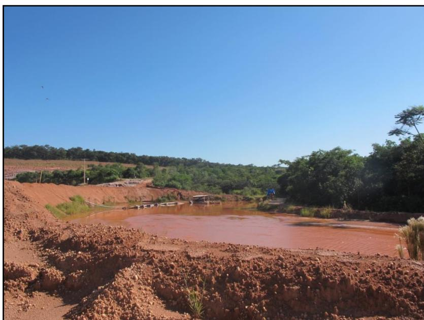
**Foto 7: Detalhe da parte da cava que está sendo preenchida com os rejeitos argilosos das operações do beneficiamento do minério.**
