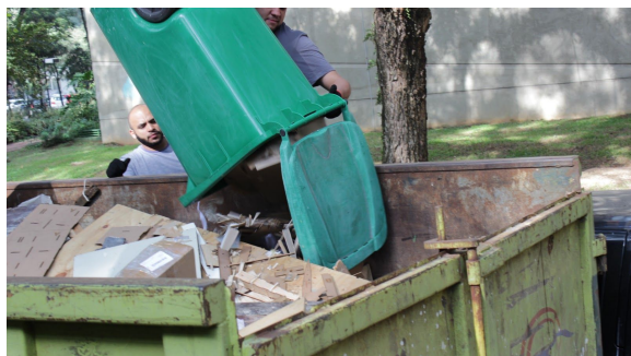
Figura 20. Funcionários descarregando os resíduos na caçamba de 30m 3
