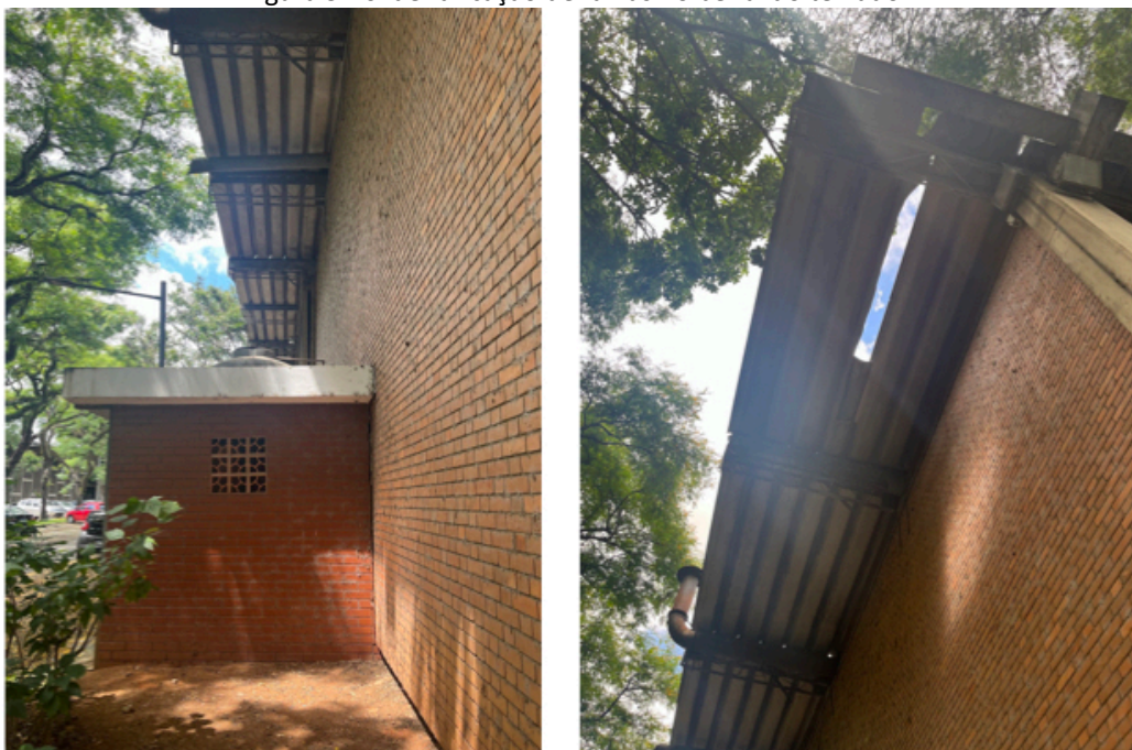
Figura 3-10 Identificação de falhas no beiral do telhado
